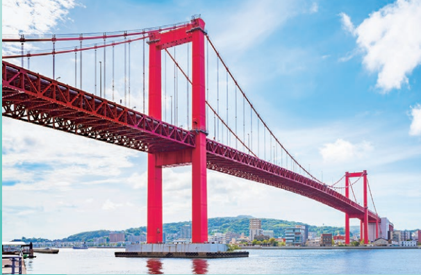
若戸大橋 (国指定重要文化財)
